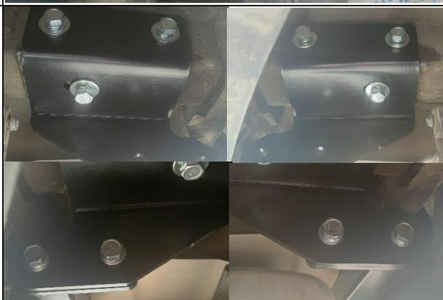
**ШАГ 3.** Установить кронштейн розетки (поз 14) и закрепить ее гайкой М8 (поз. 7) через шайбу 8 пружинную (поз. 10). Подключить электрику: розетку, жгут проводов, блок согласования (если требуется).
